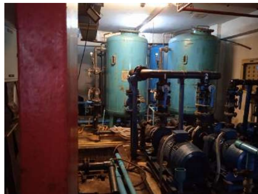
ภาพที่ 26 ระบบปรับปรุงคุณภาพน้ำใช้
